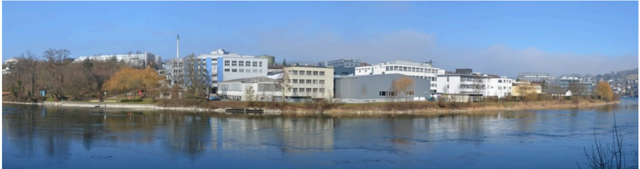
Ansicht der heutigen Bebauung
