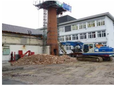
Rückbau Kesselhaus und Hochkamin
