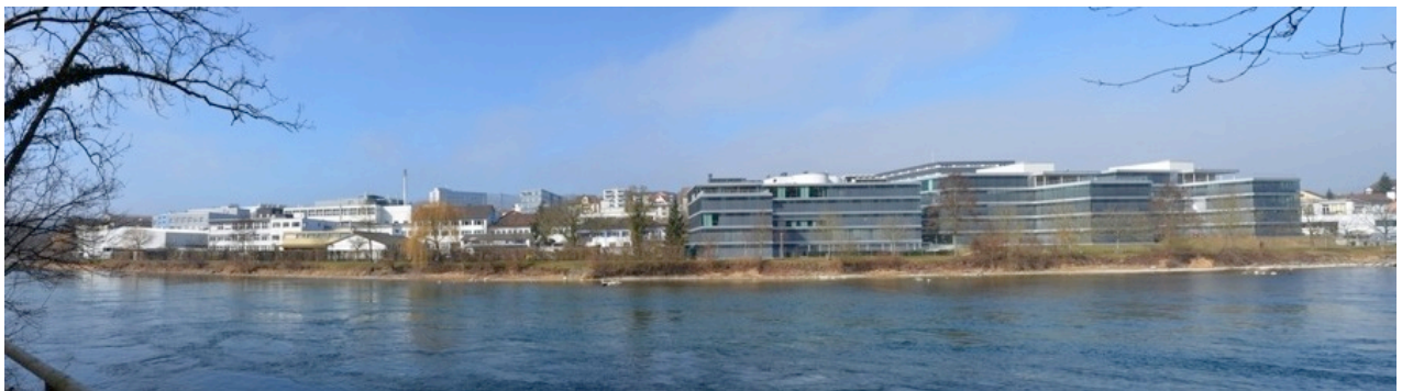
Ansicht der heutigen Bebauung
