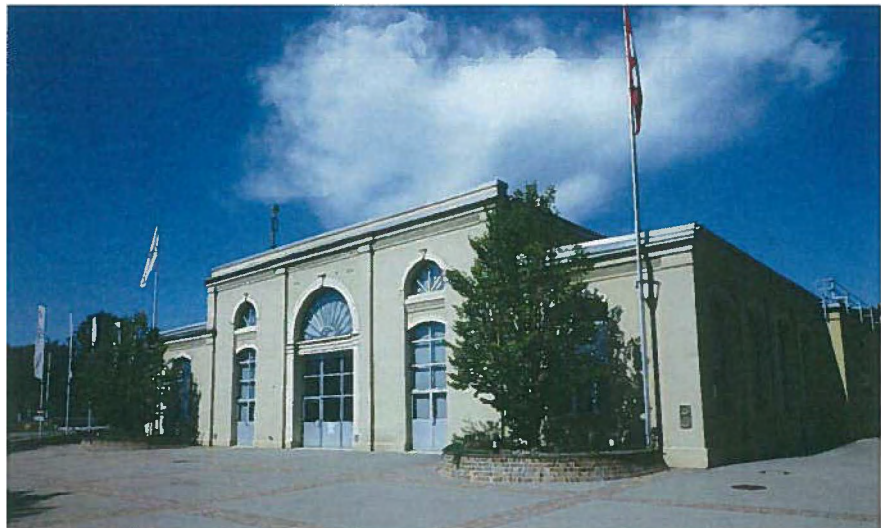
Abb. 8: Inventarobjekt VS Nr. 1715, Gebäude 22 (Kopfbau)
